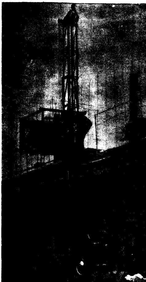
FIG. 24: Vista típica demostrando un montacargas de materiales en voladizo, móvil o portátil.
